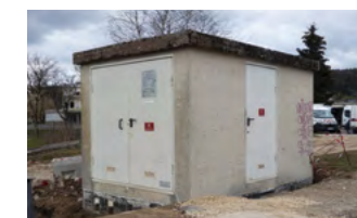
Le local avant sa rénovation
