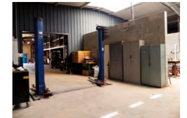
L'espace mécanique avec son pont de levage est la zone où les véhicules de la flotte municipale sont entretenus pour rester toujours disponibles pour les interventions.
